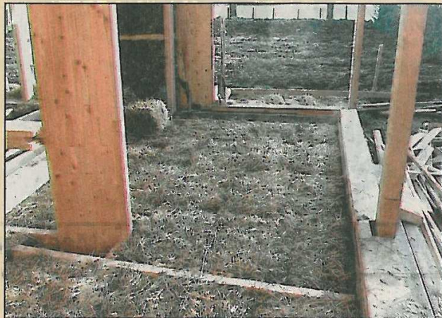
Ook in de vloer worden balen stro gestoken.
