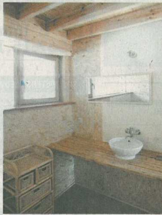
■ Hier en daar moet het leem plaats ruimen voor wanden in OSB.
