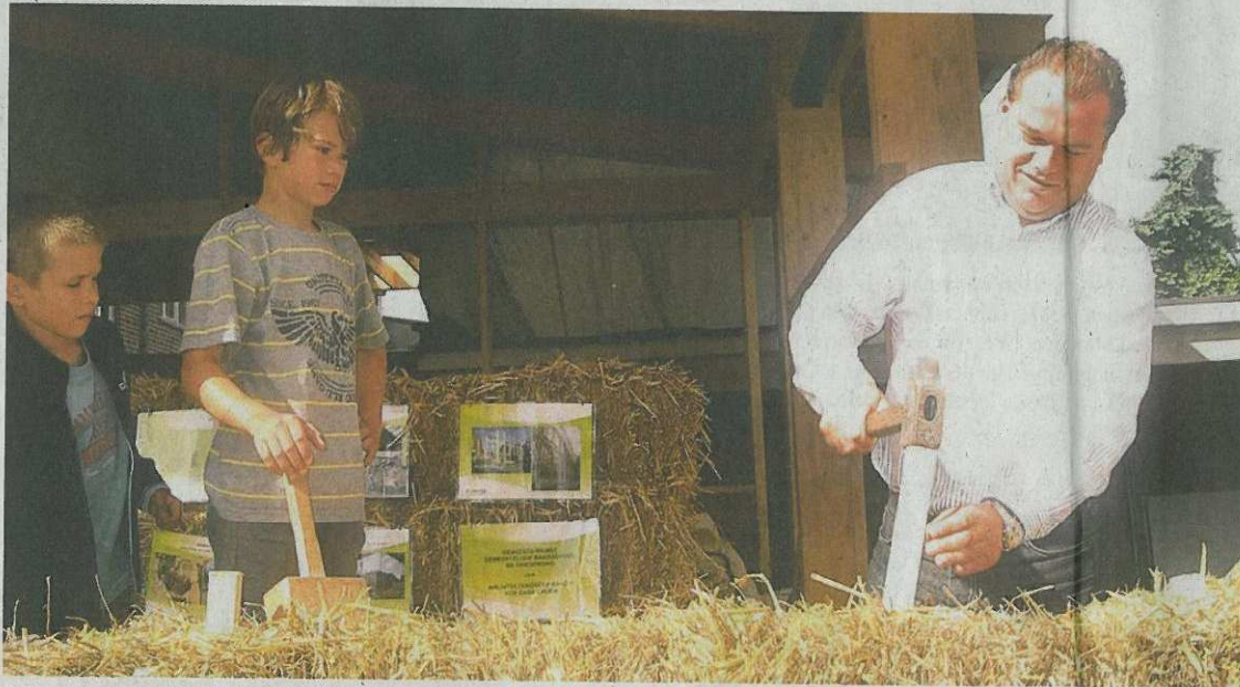
► Burgemeester Mark Vos plaatst de eerste strobalen voor de nieuwe eco-turnzaal.
